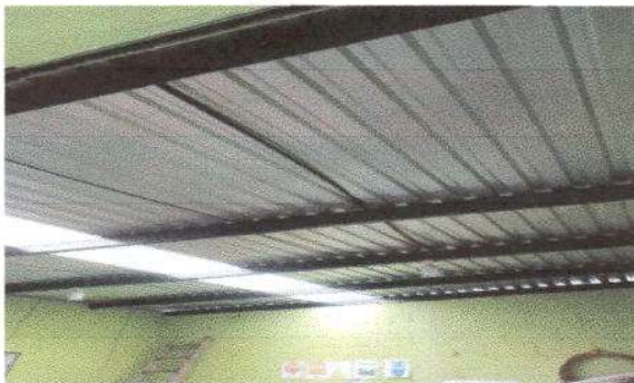
Foto 3: Mantenimiento de estructura de soporte de metal en modulo 4
