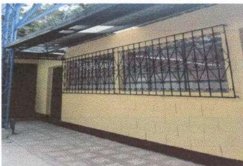
Foto 5: Mantenimiento de balcones de metal en modulo 4
