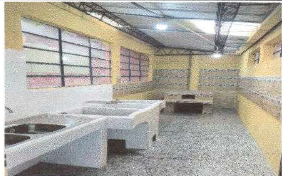
Foto 6: Instalación de piso de granito en cocina.
