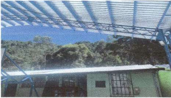
Foto 1: Instalación de lámina troquelada aluzinc calibre 26 en modulo 1
