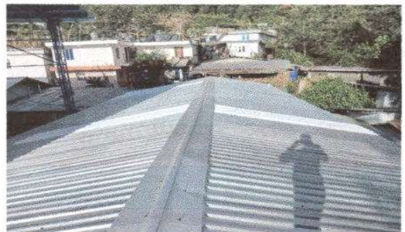
Foto 2: Instalación de capote de lámina troquelada en modulo 1
