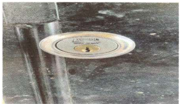
Foto 4: Instalación de chapa en puerta de cocina.
